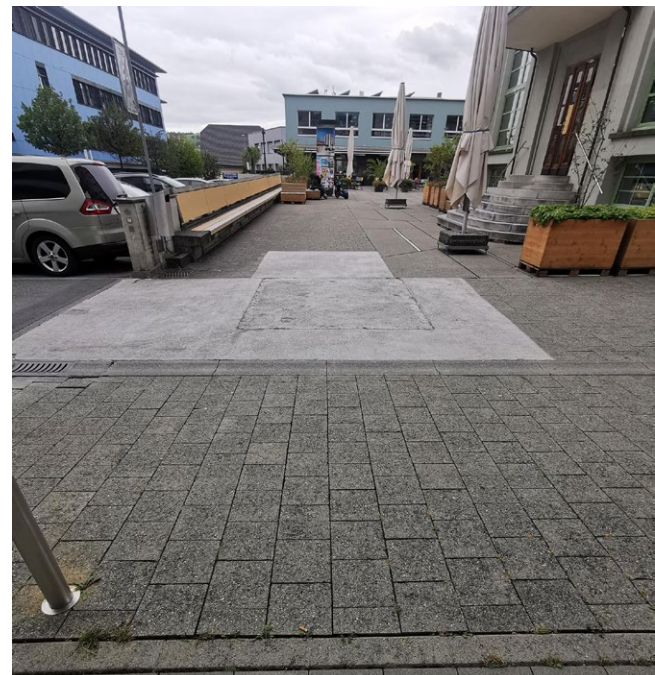
Abb. 1 Provisorische Betonverfüllung
