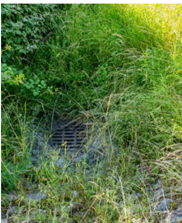
Nicht zugänglicher Schacht.
