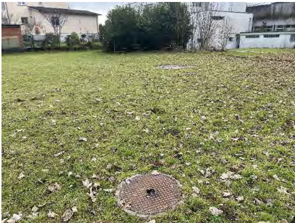
Unterirdische Anlagen auf Schafweide Nord (S8), Blr. Ost
