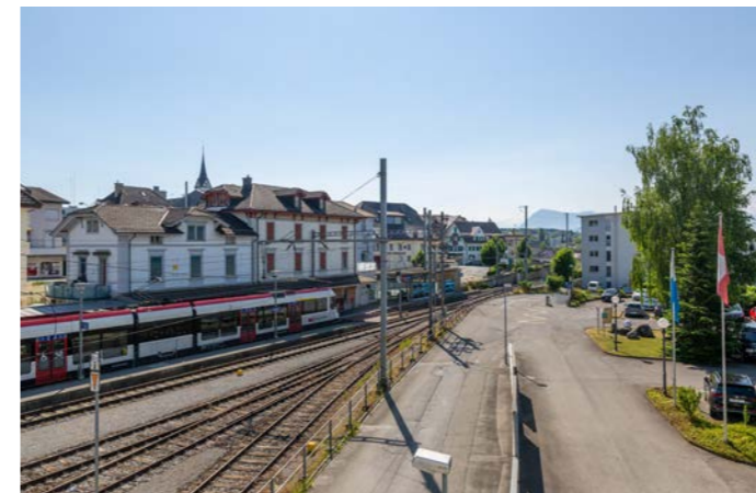
Abb. 9 Bahnhof Hochdorf und Siedereistrasse (Joris Jehle)
