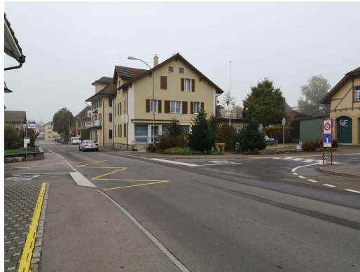
Abbildung 16: Beispiel verkehrsorientierter Strassenraum im Siedlungsgebiet (Aufnahme Knoten Bank- / Rosentalstrasse, Oktober 2022)
