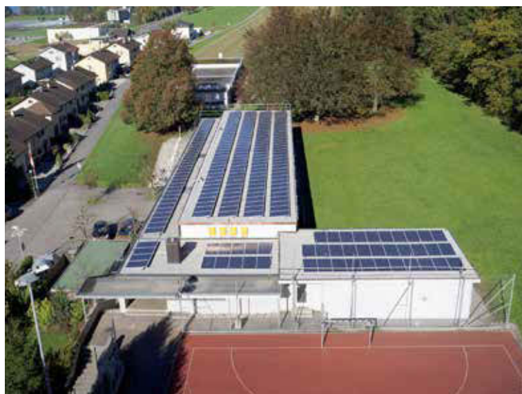
Photovoltaikanlage Schulhaus Junkerwald.
