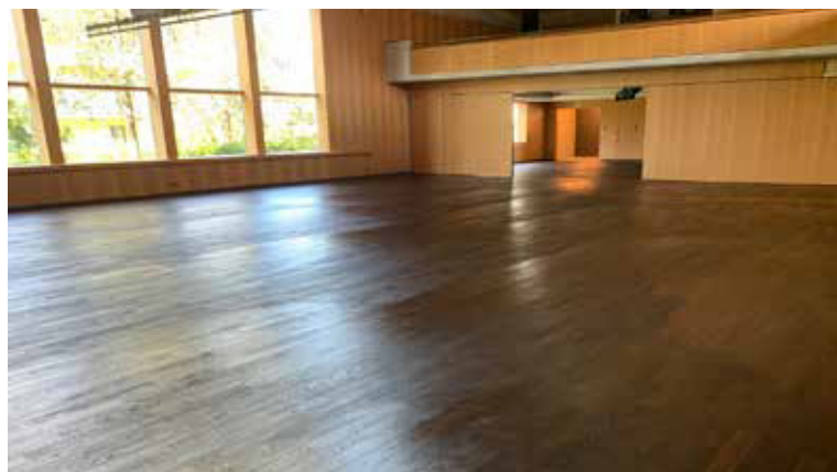
Neu verlegter Parkettboden.
