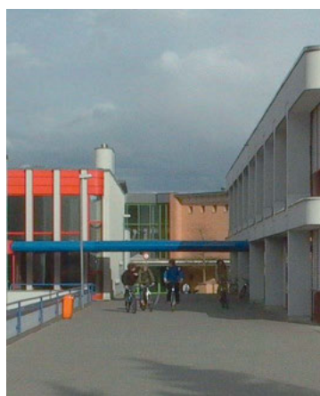
Schulhaus Avanti wird saniert.
