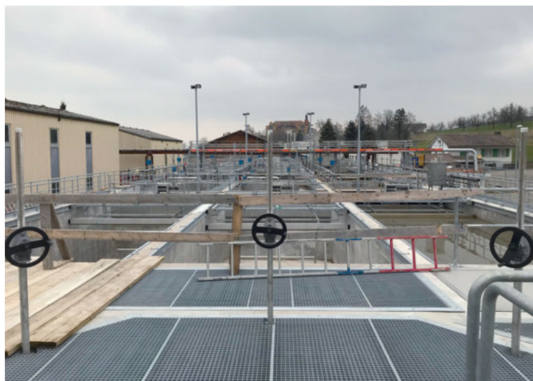
Neue Wasserstrassen im Entstehen.
