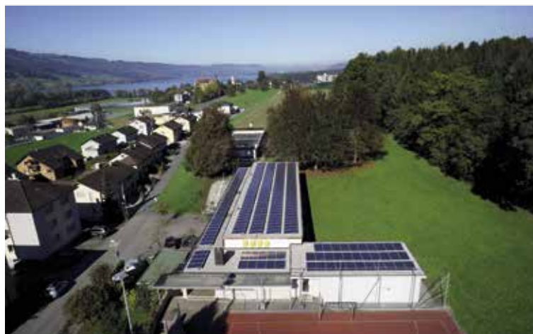
Photovoltaik-Anlage Schulhaus Junkerwald.
