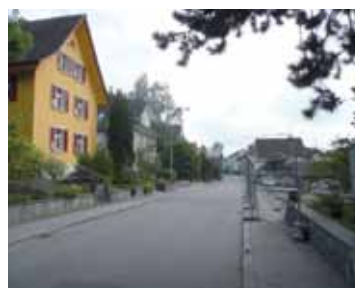
Bauarbeiten an den Werkleitungen der Kleinwangenstrasse.
