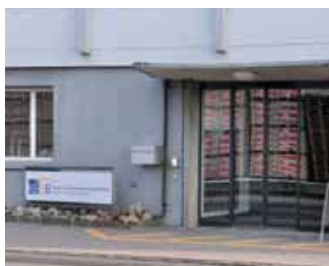
Die neue KESB an der Baldeggstrasse 20.
