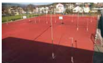
Bauprofile auf dem Sportplatz.
