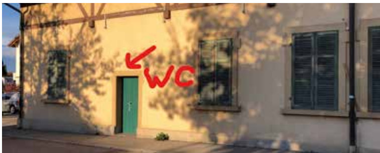
Die öffentliche WC-Anlage im Sprötzhüsi wird erneuert und auf die Seite Rosentalstrasse verschoben.
