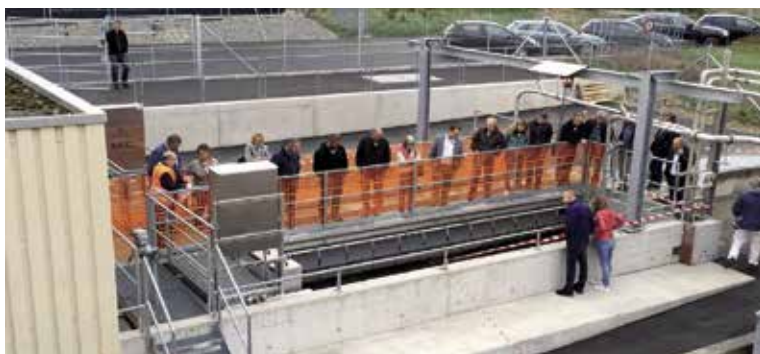
Eröffnung ARA nach Sanierung 29. September 2018.
