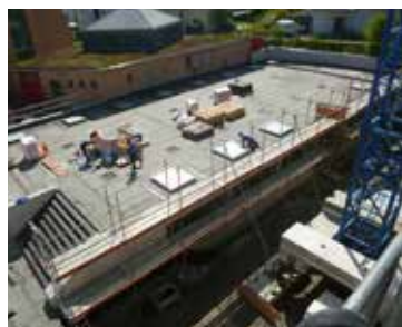
Dachaufbau neue Tagesschule.
