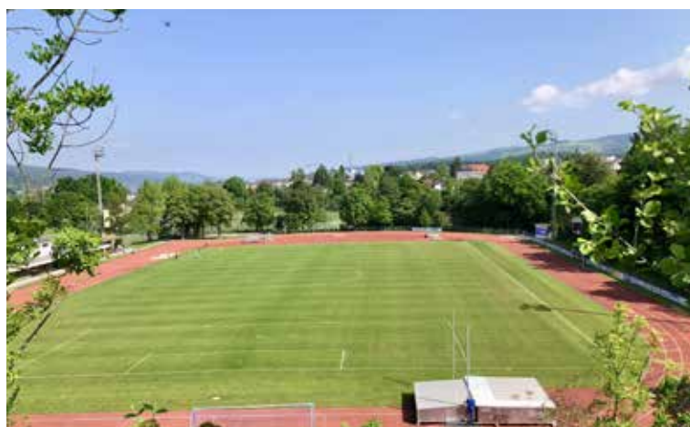
Sportanlage Arena. Top gelegen, aber nach über 40 Jahren ist eine Sanierung nun nötig.
