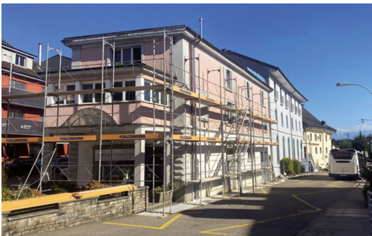
Renovationsarbeiten an der Fassade.
