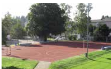
Der neu sanierte Hartplatz beim Schulhaus Zentral.
