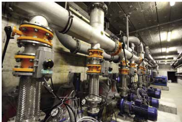
ARA-Sanierung der Technischen Anlagen.
