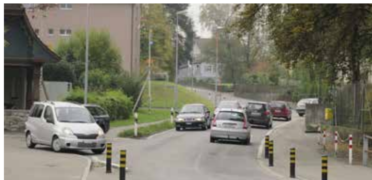
Urswilstrasse soll saniert werden.
