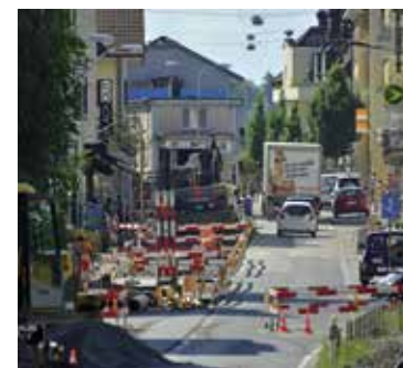
Bauarbeiten an der Hauptstrasse.
