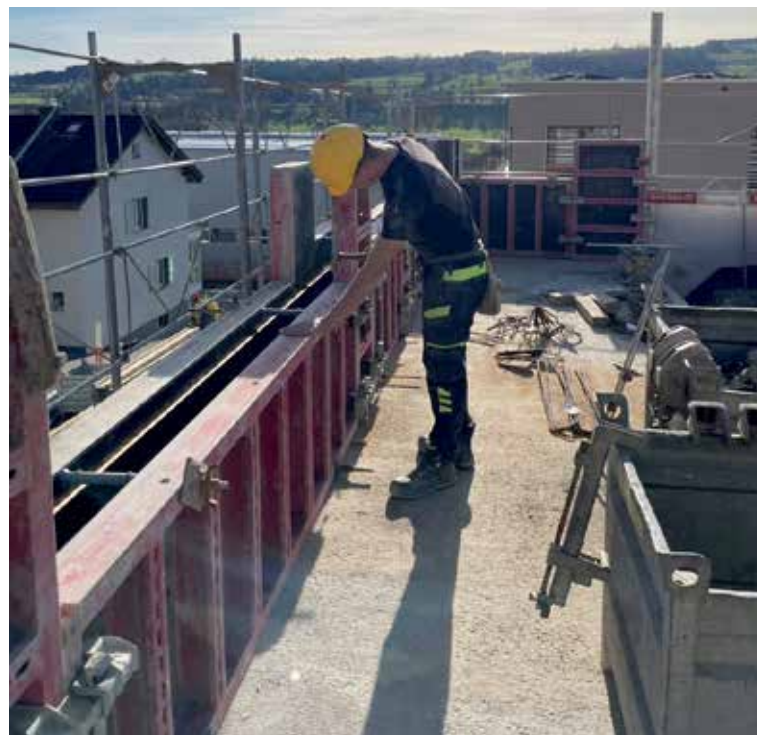
Levin auf der Baustelle.
