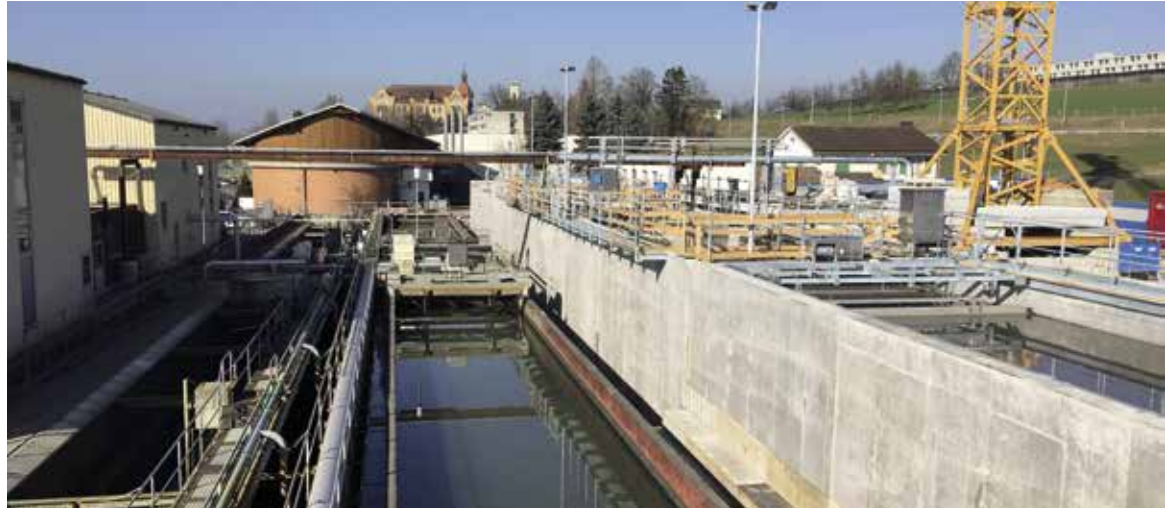
Alte Wasserstrasse (links und mitte), neue Wasserstrasse (rechts).
