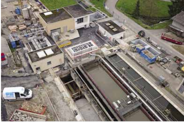
Neues Hebewerk mit provisorischer Rohrleitung.
