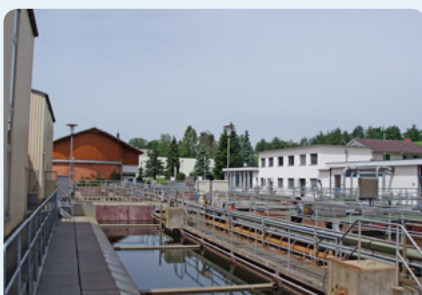
Neubau Betriebsgebäude und diverse Erneuerungen
