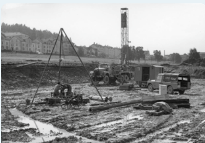
Inbetriebnahme der Anlage
