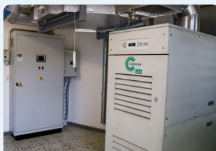
Inbetriebnahme Mikrogasturbine
