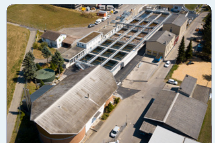
Sanierung und Ausbau der Anlage
