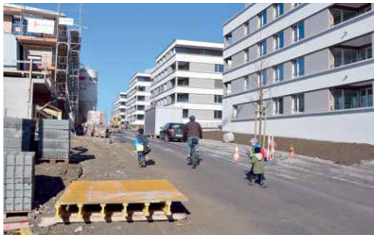
Das neu entstehende Quartier Hengsthöhe.
